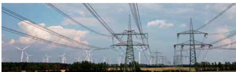
Wer die erneuerbaren Energien will, muss gleichzeitig dafür sorgen, dass jederzeit genügend Strom durch die Leitungen strömt. Foto: Q.pictures, pixelio.de
